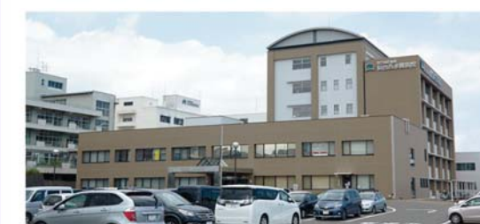
仙台西多賀病院(宮城県仙台市) 許可病床数 480床
