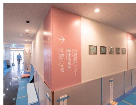
新病院（工事中）
