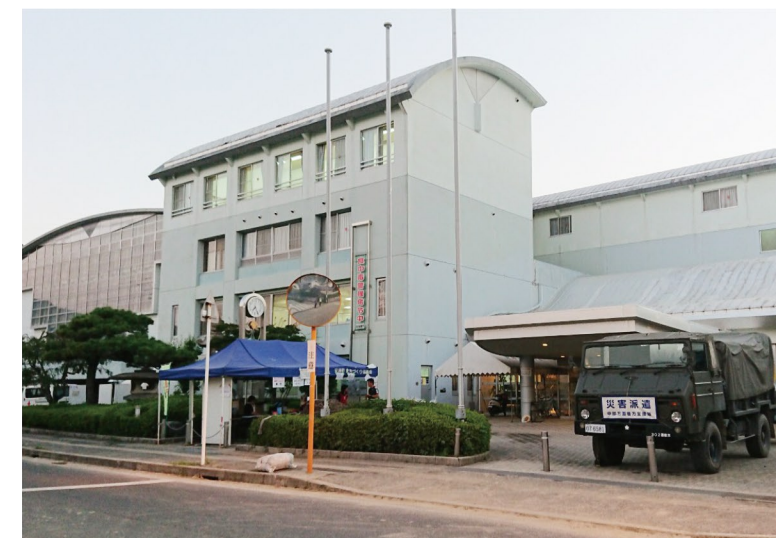
避難所となった広島県呉市安浦地区の安浦町づくりセンター
