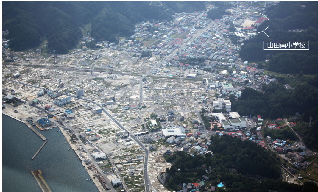
岩手県下閉郡山田町： 平成23年9月16日撮影 (国土地理院)
