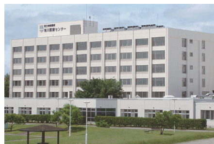
平成22年に建替えた病棟の外観
