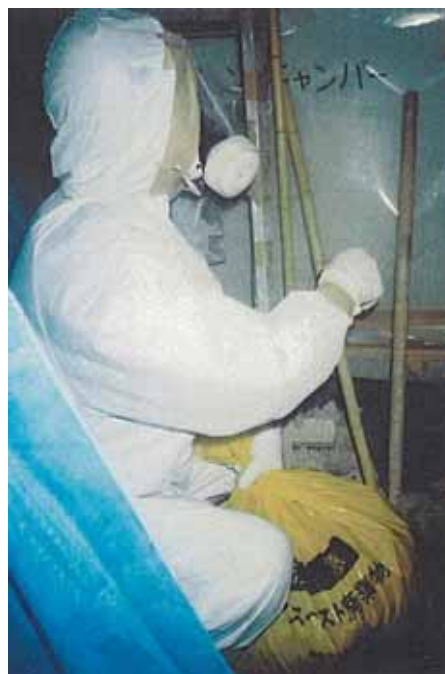
アスベスト集積袋詰め状況
