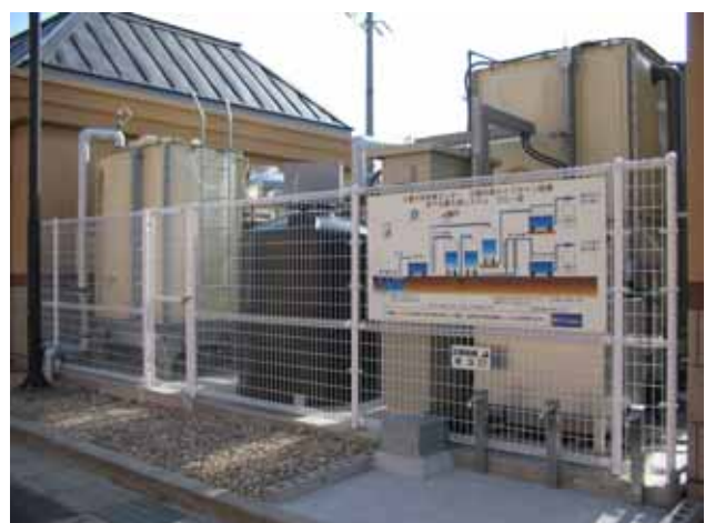
システム全景（右下は供給用蛇口）
