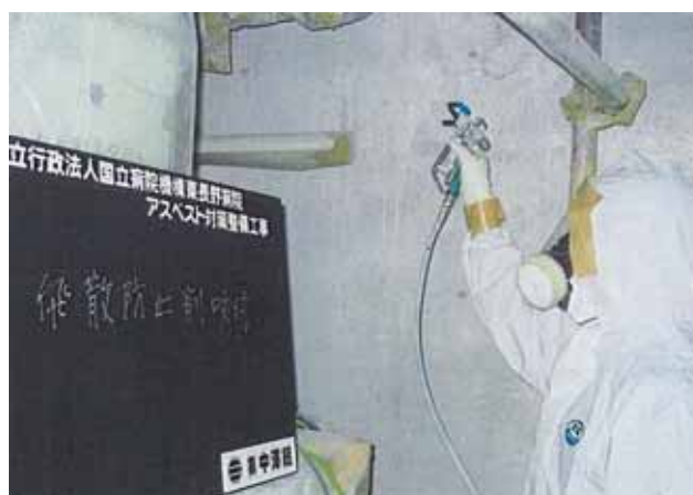
飛散防止剤吹付け状況
